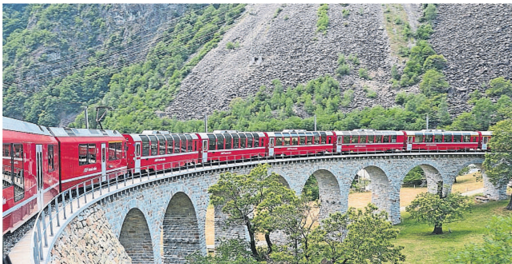
Schweiz Bernina Express am Kreisviadukt
